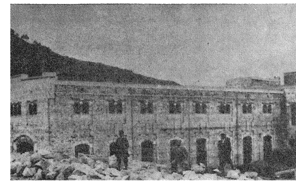
鹿留発電所竣工
