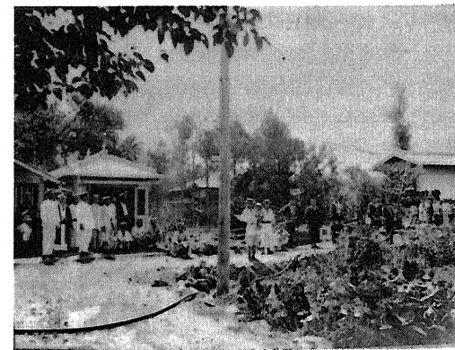
宮下組水道通水寄付（大正10年8月10日）
