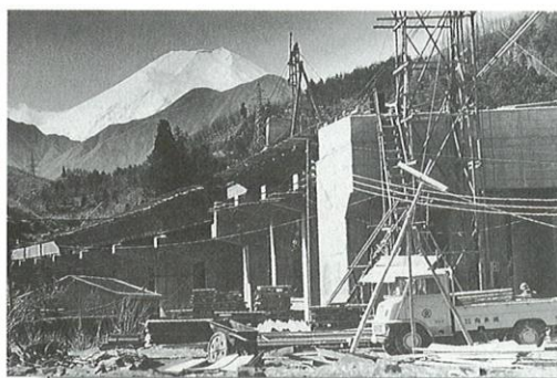
建設中の中央自動車道
