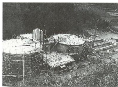
大月都留衛生組合「桂川衛生センター」
