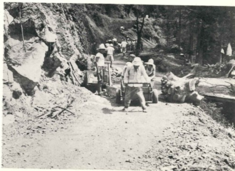
道路新設工事
