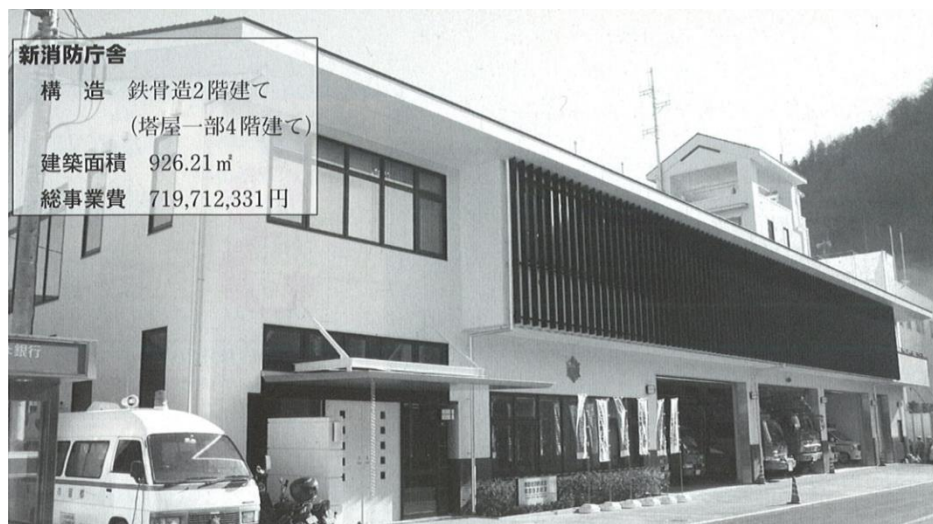
都留市新消防庁舎が完成
