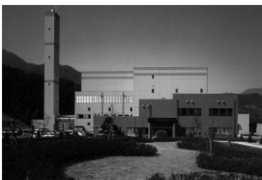
大月都留広域事務組合の新ごみ処理施設
