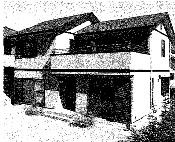
No.10号棟(外観)
