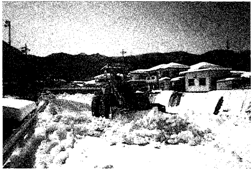
市道の除雪作業の様子
