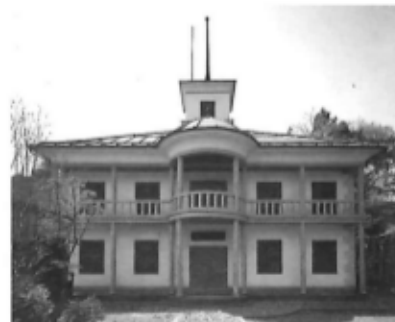
尾県郷土資料館では、毎年、文化財防火デーに防災訓練を行っています
