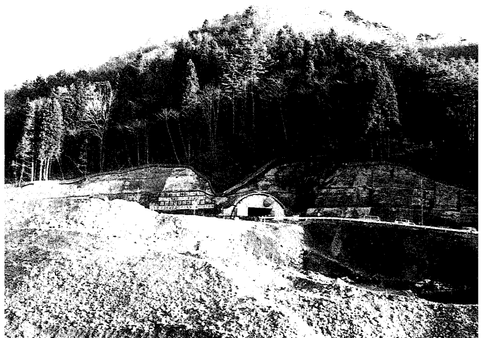
リニアモーターカー実験線建設（大平地内）
