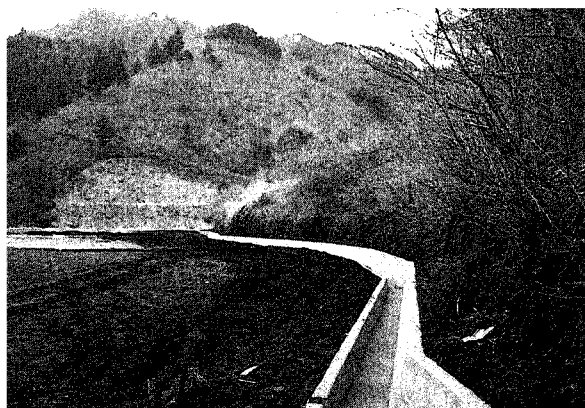
農業用水路改修
