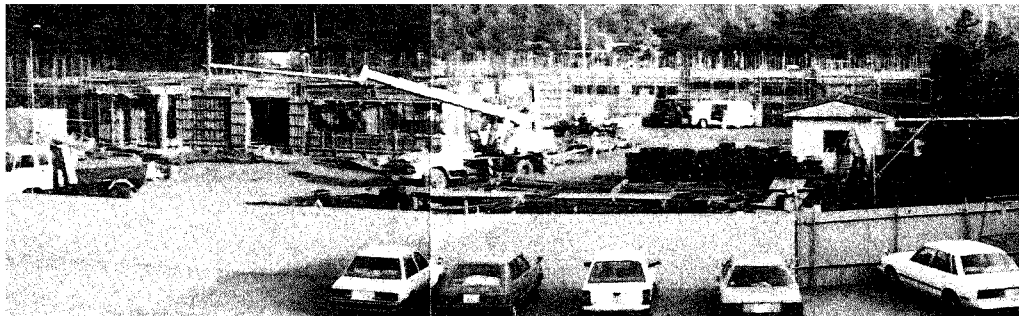
▲着々と工事が進む禾一小校舎
