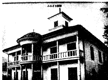
旧尾県学校校舎
