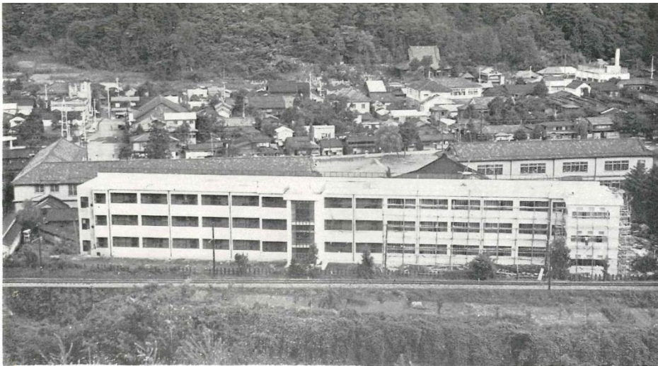
谷村第一小学校舎
