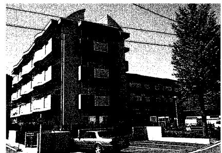
完成した田原団地3号棟
